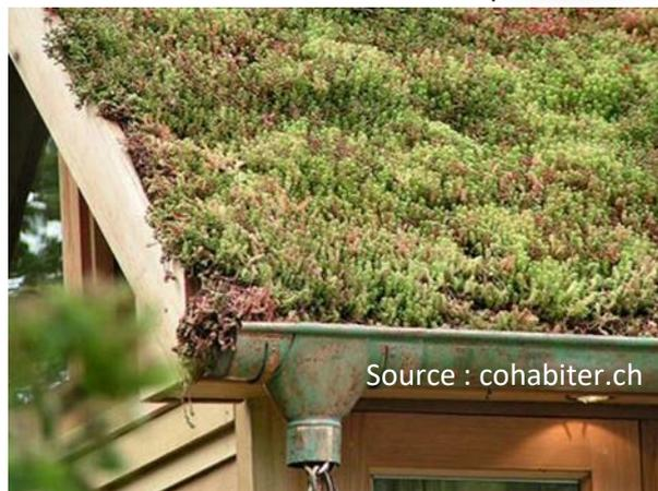
L'été, les plantes d'un toit vert **protègent l'immeuble contre les rayons solaires** et, grâce au phénomène d'évapotranspiration, peuvent atténuer voire éliminer les gains thermiques, ce qui **contribue à rafraîchir** et à réduire les besoins énergétiques en climatisation du bâtiment. L'hiver, l'isolation supplémentaire fournie par le substrat contribue à **réduire les besoins énergétiques** en chauffage de l'immeuble.
